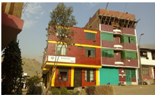
Estación Samusocial Huaycán después de su remodelación Setiembre 2015
